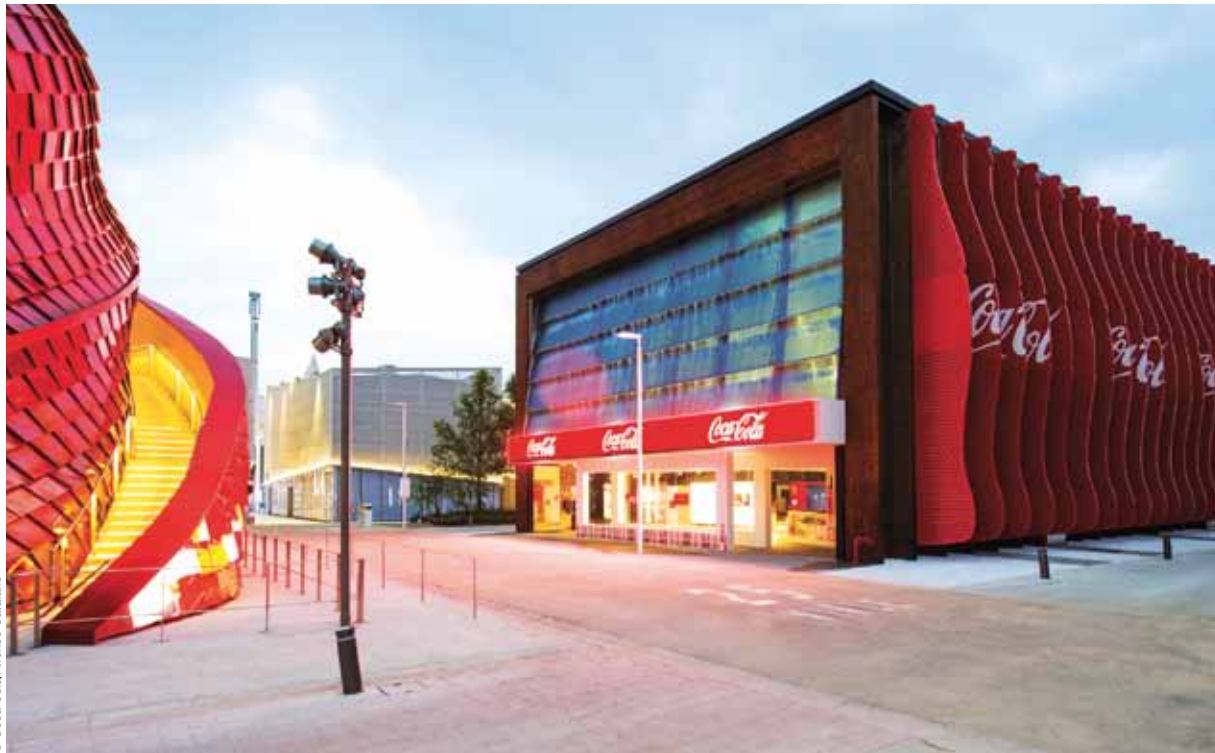
Ein Pavillon, der mehrere Zwecke erfüllt und vor allem der Umwelt gerecht wird: Coca-Cola auf der Expo in Mailand.
