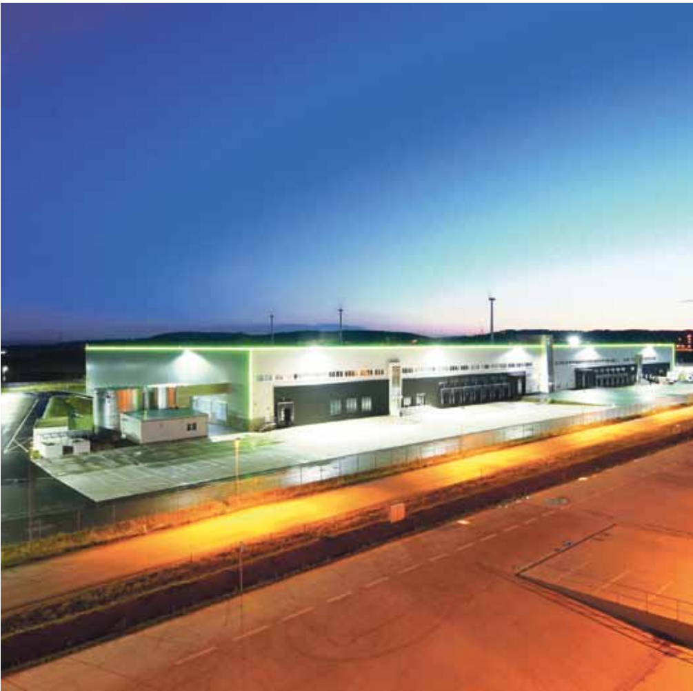
Das neue A1 Logistikcenter in Hagenbrunn bei Wien.
