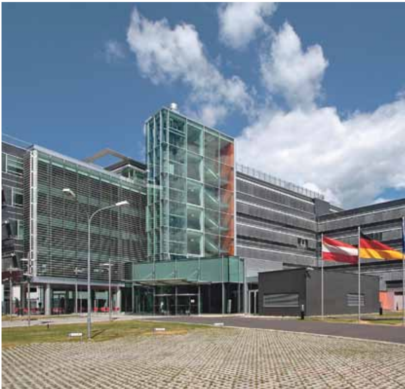
Der Boehringer Ingelheim-Standort in Wien wird noch einmal massiv ausgebaut.
