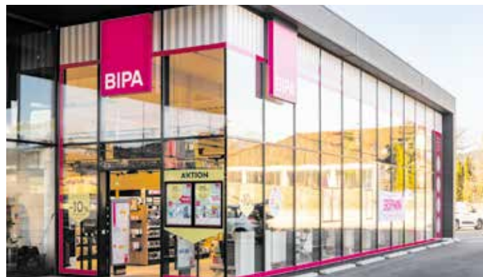
In der Filiale werden Maßnahmen zur Erhöhung der Energieeffizienz gesetzt.
