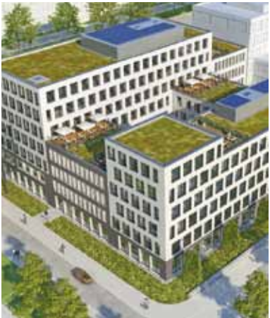
„twin yards“ in München Schwabing soll im 4. Quartal 2015 fertiggestellt sein.
