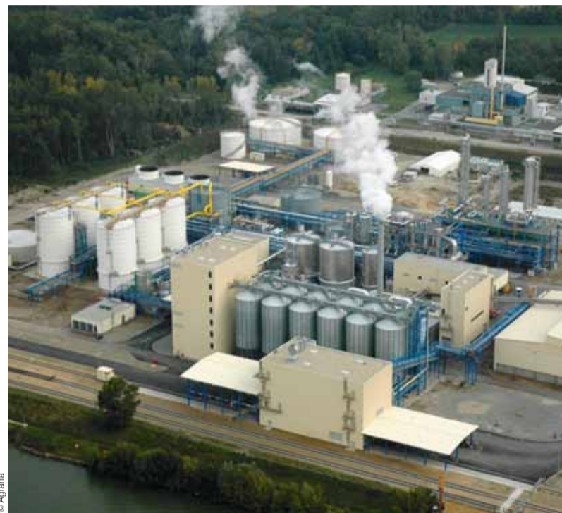
Die Bioethanolanlage in Pischelsdorf wird technisch ständig weiter „aufgerüstet“.
