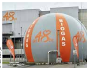
Die neue Biogas-Aufbereitungsanlage der Wien Energie in Simmering.
